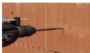
1/ Pré-percer au Ø8 sur la profondeur souhaitée.
