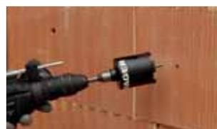
3/ Placer le guide centreur avec le trépan dans le pré-trou afin d'amorcer le carottage.
